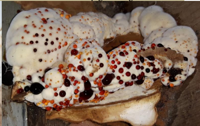
Larmes de polypore ( Donkioporia expansa ) sur une solive.
