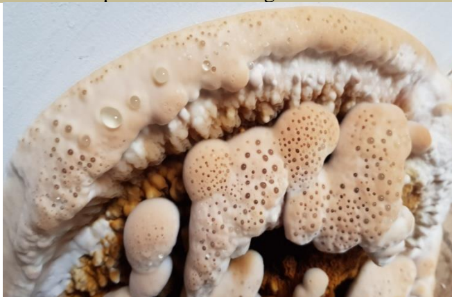
Larmes de mérule ( Serpula lacrymans ) sur une plinthe.
