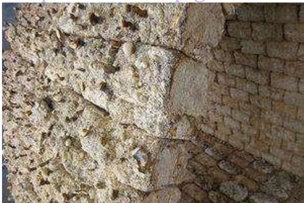
Construction en briques de mycélium de champignon.
